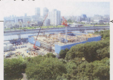
桜堤中 校舎建築の様子
