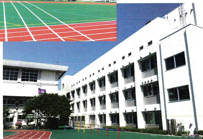
プール棟 2023年3月完成
